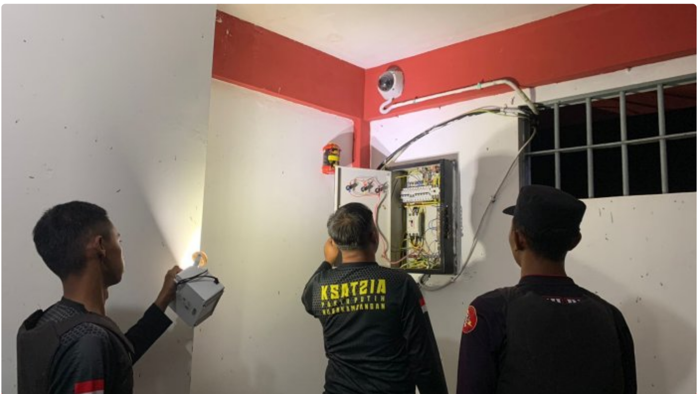
Pengecekan jaringan listrik antisipasi terjadinya korsleting listrik oleh petugas Lapas Pasir Putih
