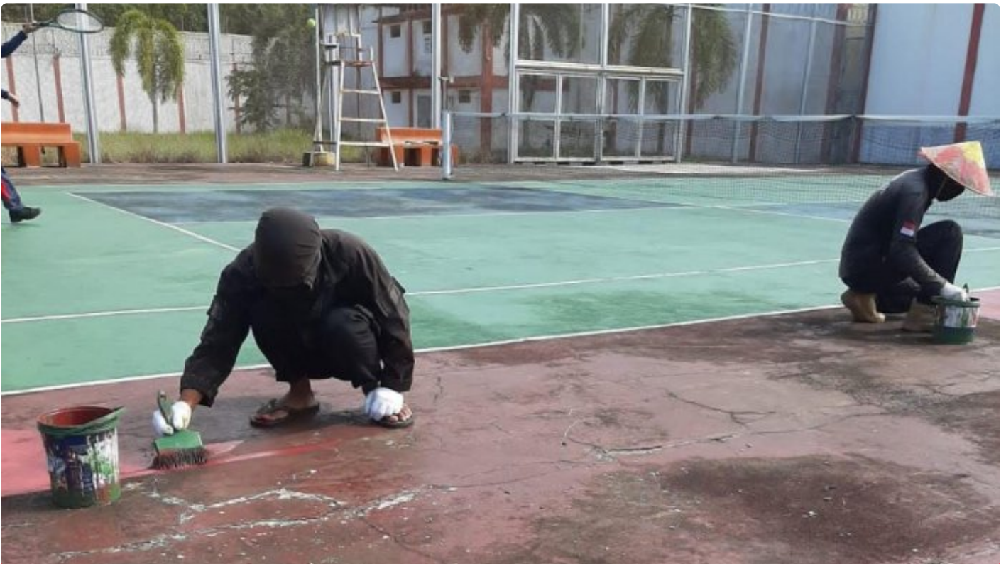
Lapas Pasir Putih Gelar Kegiatan Perawatan Gedung dan Bangunan Lapas
