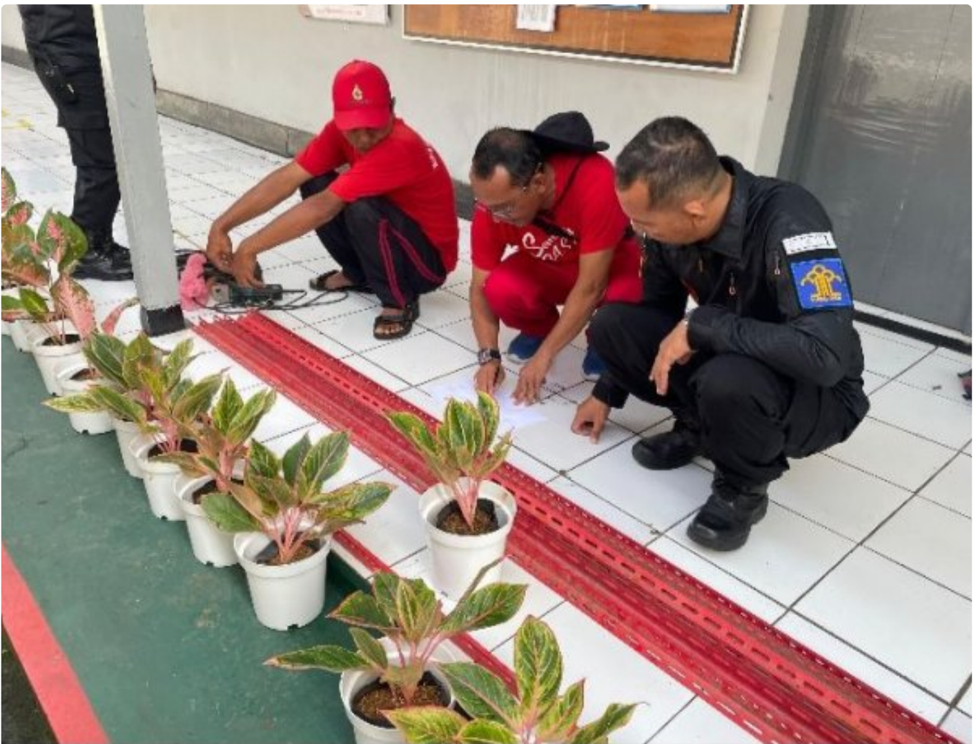
Perindah Lingkungan, Lapas Besi Lakukan Renovasi Area Kantor
